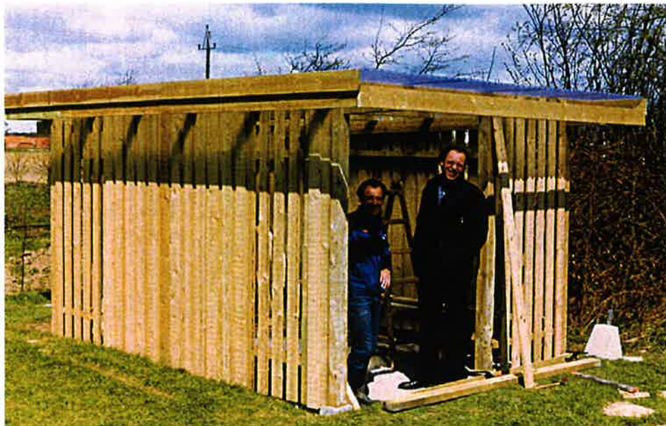
Skuret på fællesarealet blev opført i 1982.
